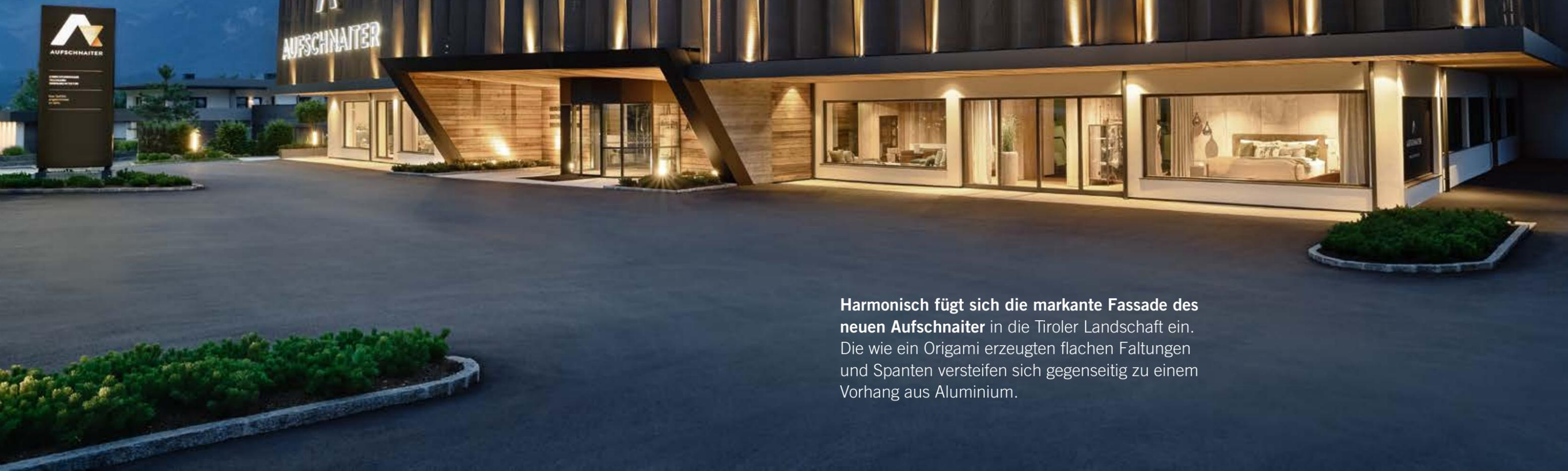
Harmonisch fügt sich die markante Fassade des neuen Aufschnaiter in die Tiroler Landschaft ein. Die wie ein Origami erzeugten flachen Faltungen und Spanten versteifen sich gegenseitig zu einem Vorhang aus Aluminium.
